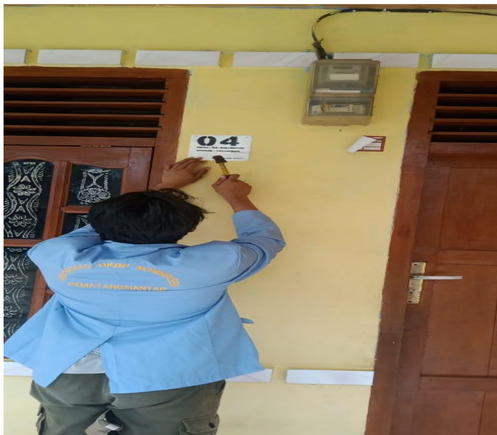
Gambar 3 Pemasangan Nomor Rumah
