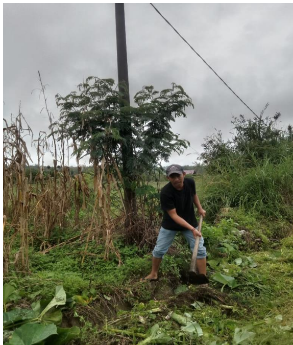
(Gambar 1. Pembersihan Jalan )
